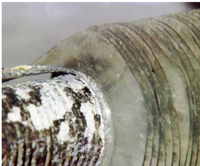
FIG. 6 La pulvérisation d'eau permet d'assouplir le faisceau de type L-Wrap.
